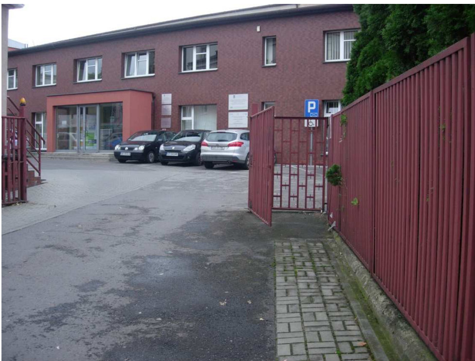
Fotografia nr 2 Ogrodzenie wjazdu na teren ZIM sp. o.o.
