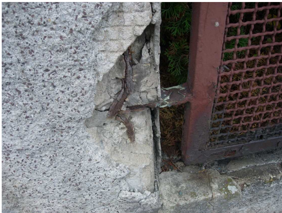
Fotografia nr 5 Korozja ogrodzenia oraz uszkodzenia w miejscach mocowania paneli
