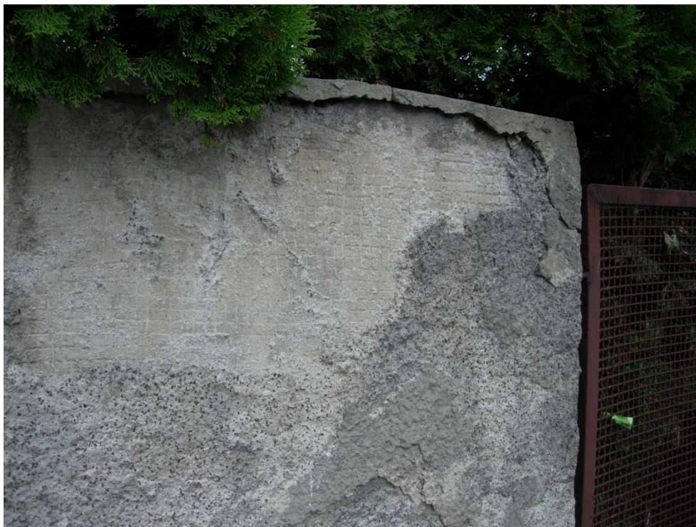
Fotografia nr 6 Odpadający tynk na betonowym słupie
