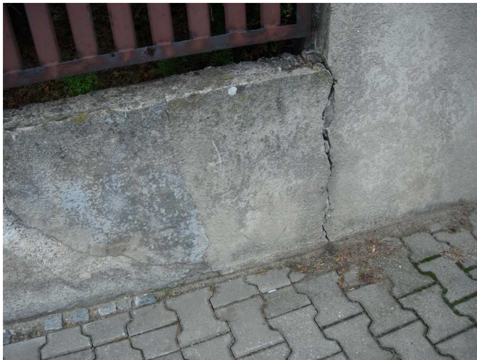
Fotografia nr 4 Pęknięcia betonowego cokotu, na stykach ze słupem.
