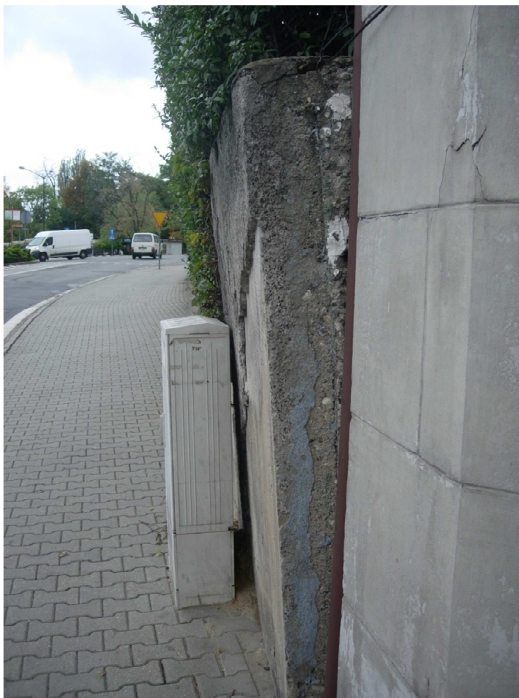
Fotografia nr 3 Odchylenie od pionu ogrodzenia sąsiedztwie budynku nr 14 przy ul. K. Prusa
